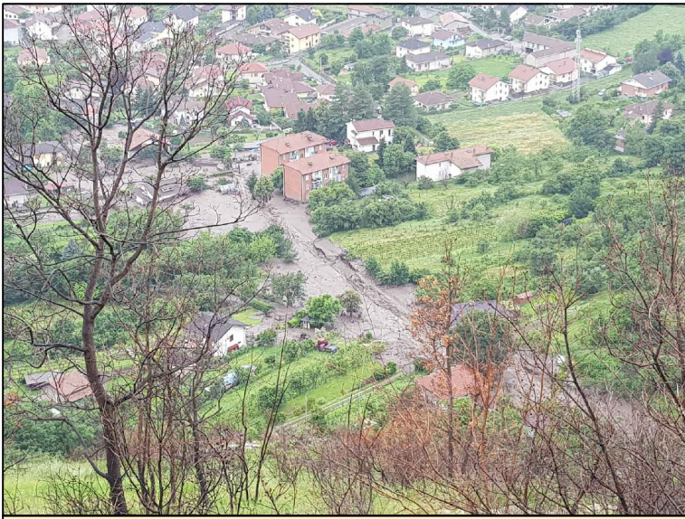
FOTO 01: Vista da monte del fenomeno di debris-flow avvenuto in data 07/06/2018
