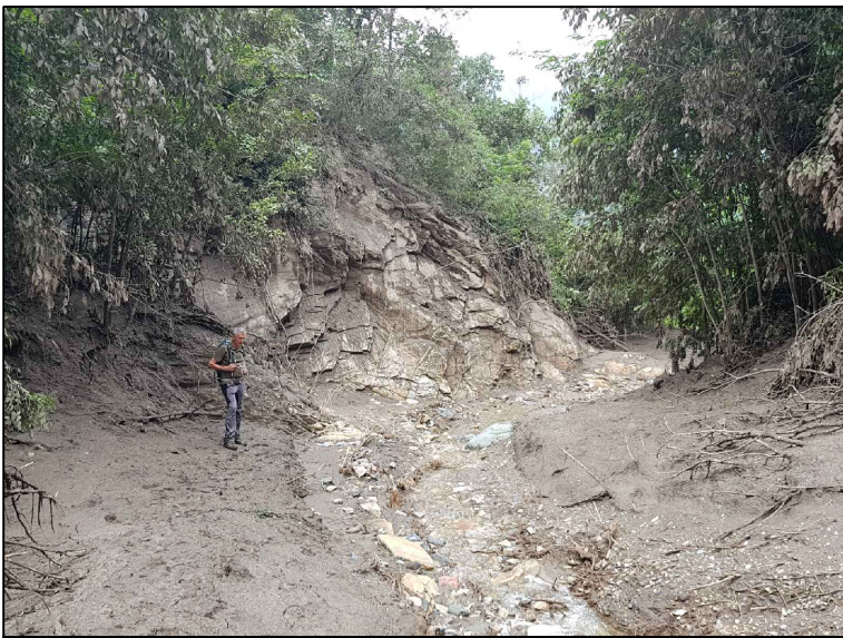
FOTO 02: Vista di dettaglio del tratto in apice di conoide al piede del salto esistente nel massiccio roccioso
