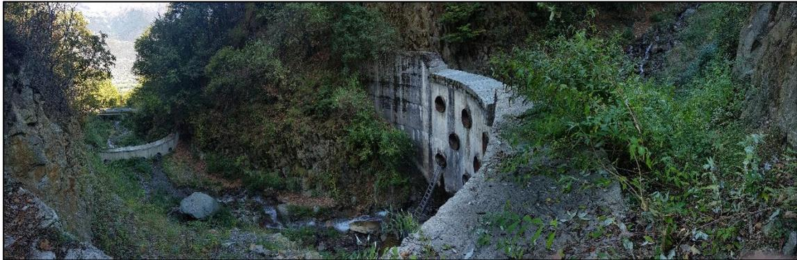
*Figura 6 – Ripresa fotografica, da monte verso valle, delle due briglie selettive in c.a. a monte delle della viabilità secondaria esistente*
