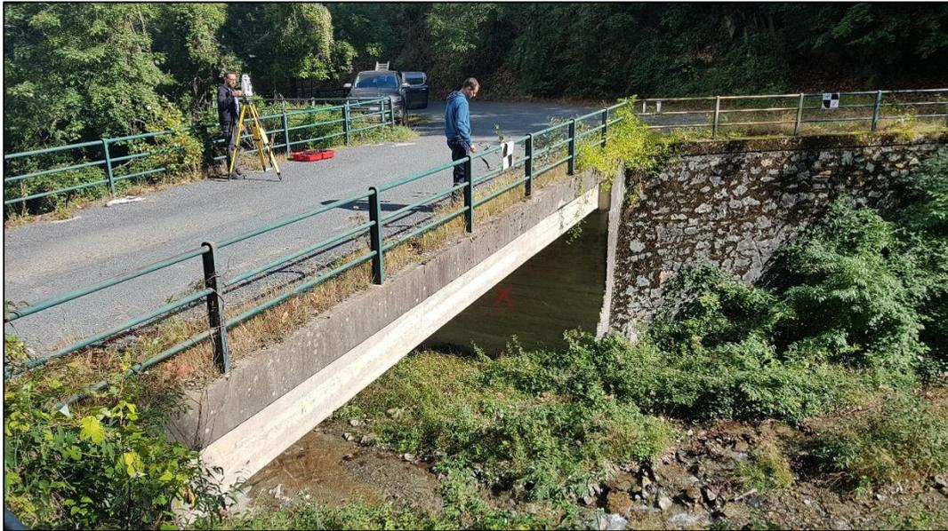
*Figura 15 – Operazioni di rilievo mediante l'utilizzo di stazione totale e laser scanner*
