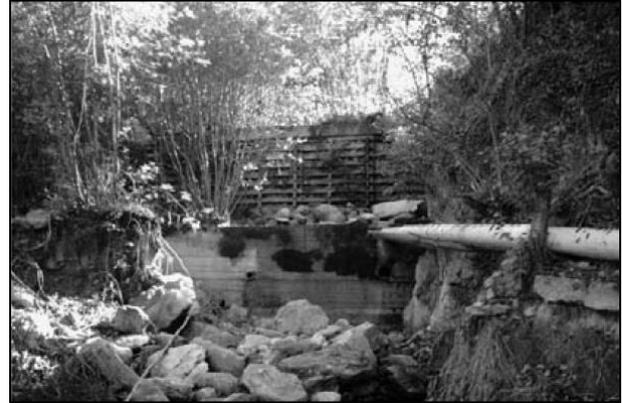
*Figura 7 – Riprese fotografiche, da valle verso monte, delle briglie selettive DAMIBR009 e DAMIBR018 esistenti lungo il rio Pissaglio, la cui capacità di trattenuta è del tutto trascurabile rispetto alle esigenze.
