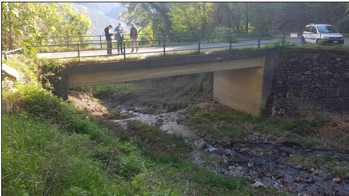
*Figura 4 – Manufatto di attraversamento lungo il Rio Pissaglio (DAMIP002) ubicato lungo viabilità secondaria, a valle delle due briglie selettive*
