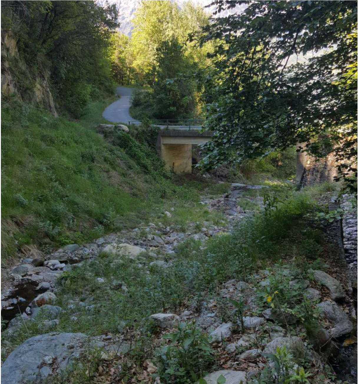
L'alveo appena a monte del ponte P28 (sottobacino B). Il ponte coincide con la sezione di chiusura del sottobacino B. Tale tratto di alveo appare indicato per l'eventuale realizzazione di un'ulteriore opera di contenimento del trasporto solido
