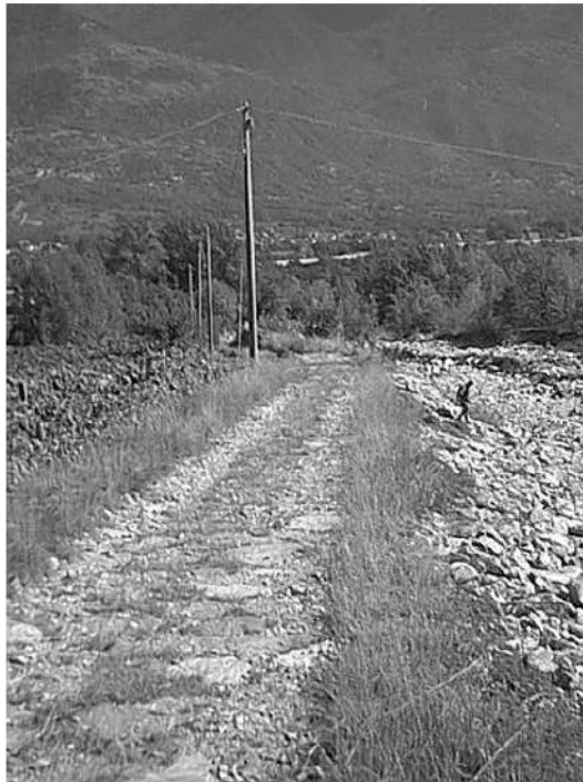
Fotografia 25 - Argine in terra in sponda destra (scheda censimento opere idrauliche n° DAMIDS010, allegato 2).
