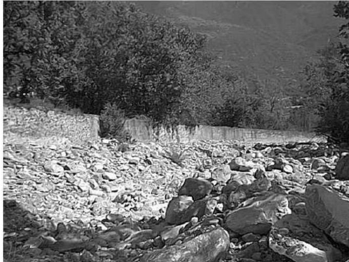
Fotografia 24- Muri di sponda in sinistra (scheda censimento opere idrauliche n° DAMLAR005, allegato 2).
