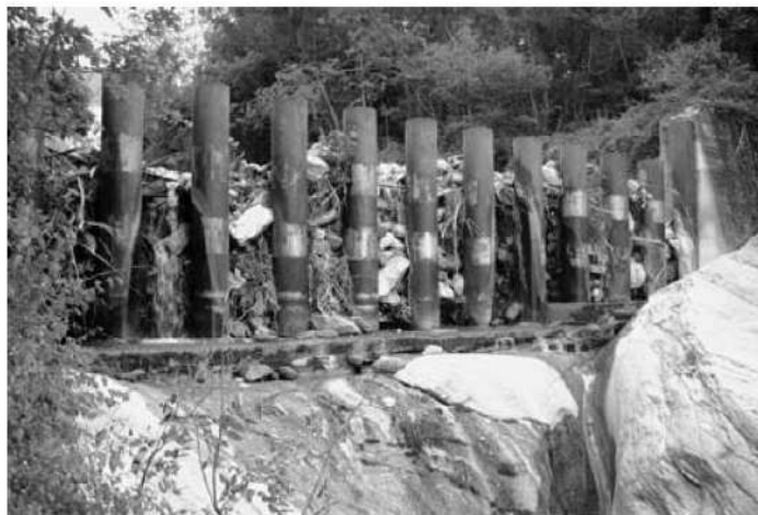
Fotografia 22 - Briglia a pettine vista da valle (scheda censimento opere idrauliche n° DAMIBR009, allegato 2).
