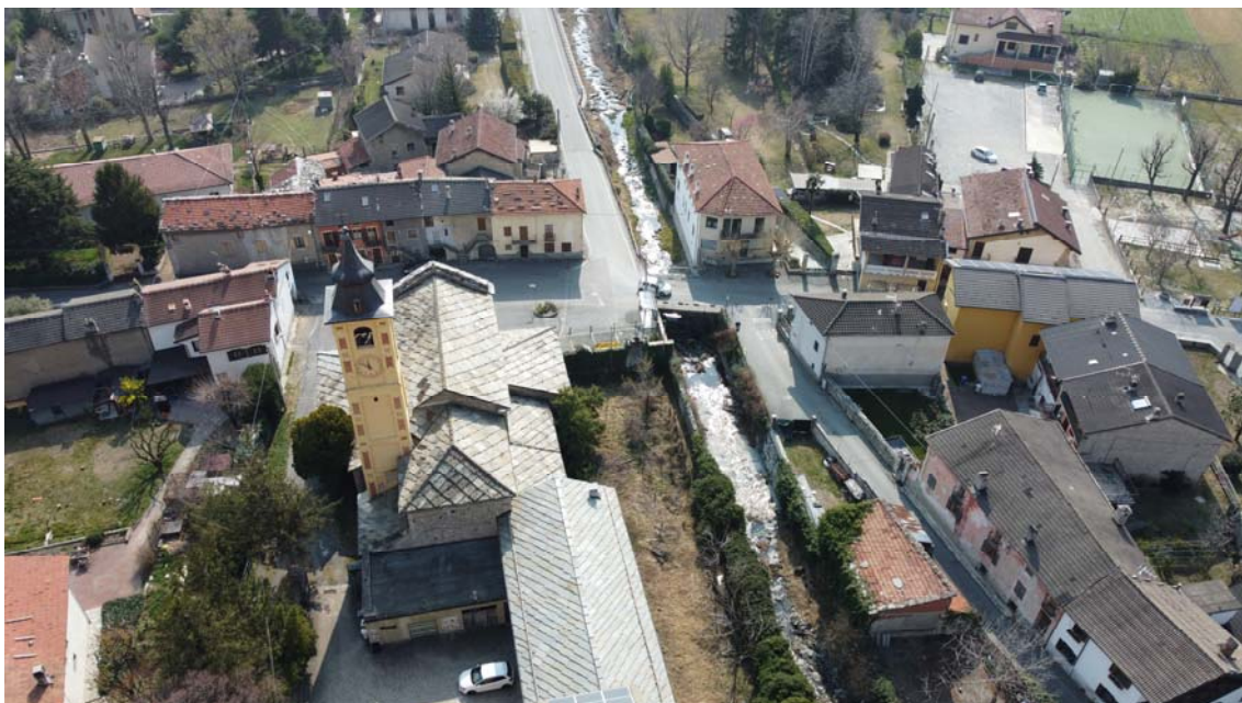
Vista del ponte di Via Gran Porta
