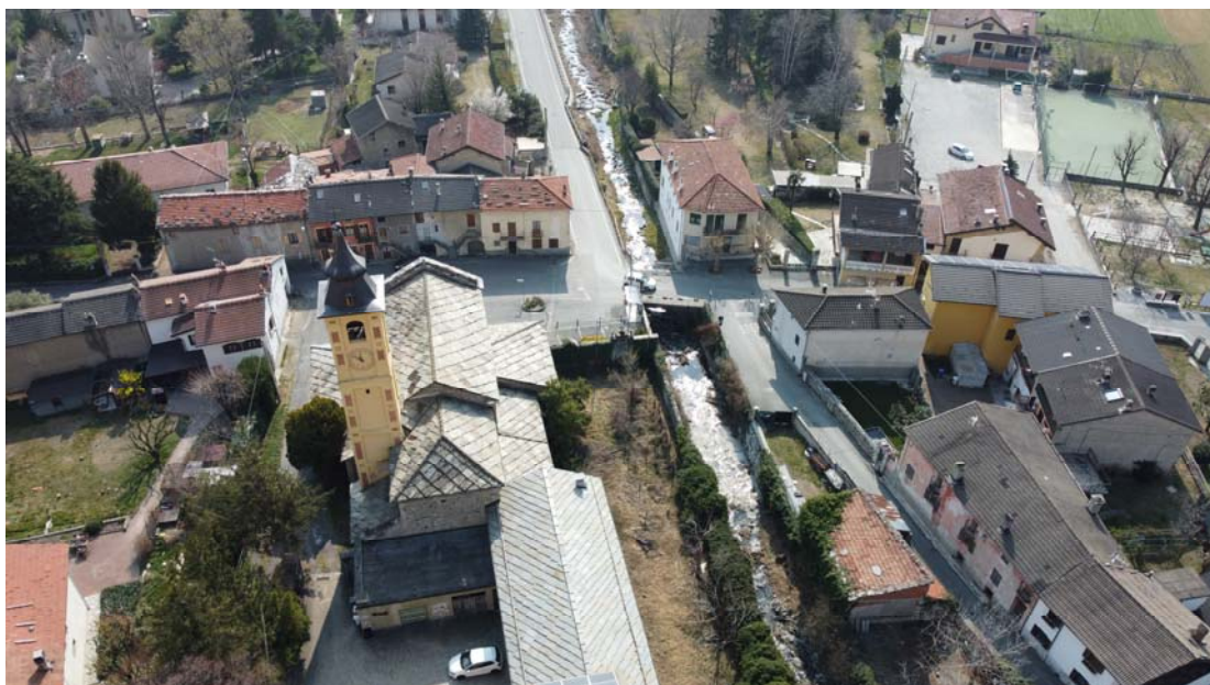
Vista del ponte di Via Gran Porta
