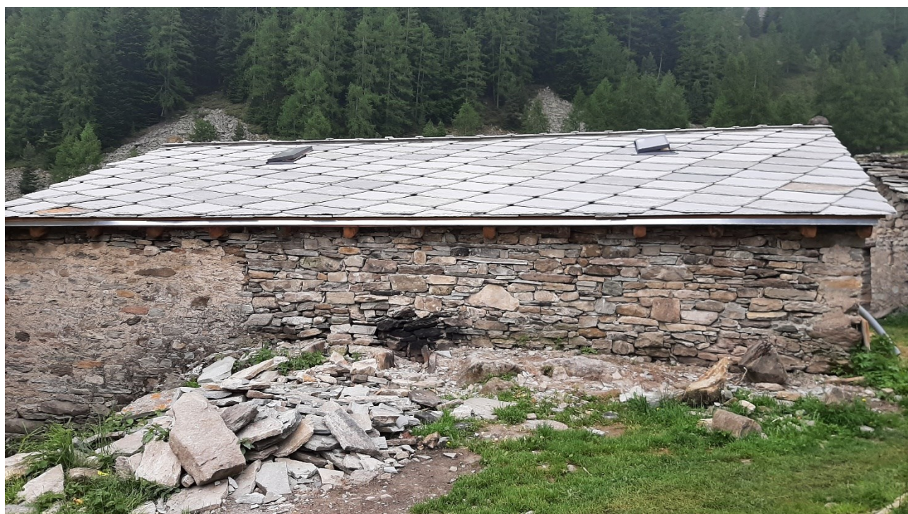
Fabbricato A – X 353.794 Y 4.994.642
