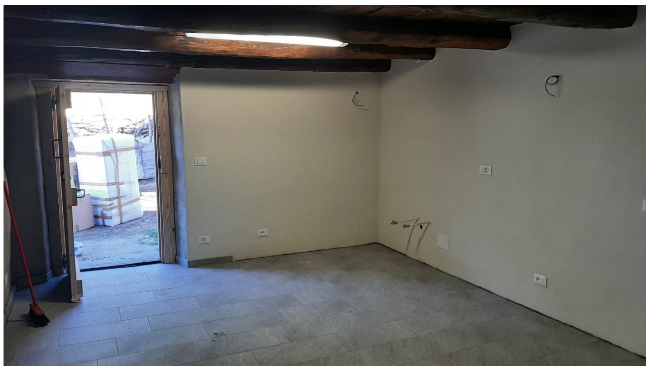
Fabbricato B – X 353.800 Y 4.994.645
