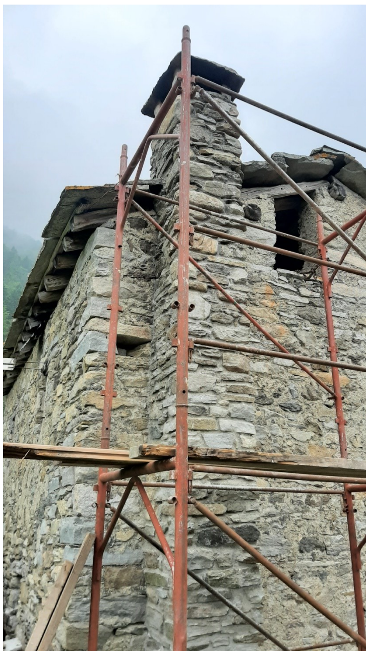
Fabbricato B – X 353.801 Y 4.994.654
