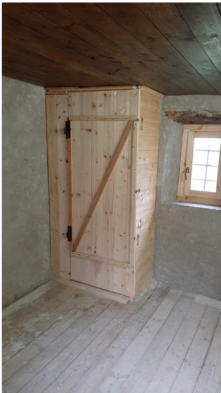
Fabbricato B – X 353.802 Y 4.994.647
