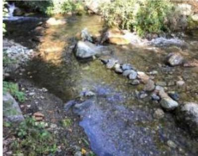
Derivazione Loc. Combe: traversa in materiale sciolto
