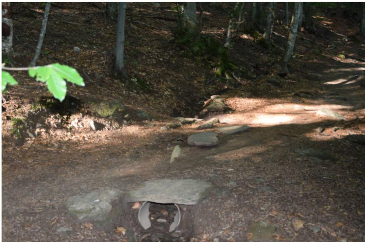
*Attraversamento G7 dove si prevede lo scavo manuale, la sostituzione del tubo e risistemazione dell'imbocco e dello sbocco.*
