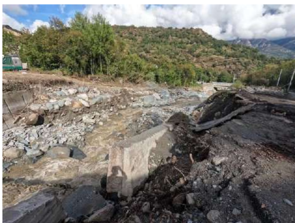
Figura 28. A sinistra: sponda del rio Gerardo a valle del ponte superiore dei Giordani: in primo piano il muro in cls parzialmente abbattuto. A destra: uno degli autoveicoli travolti dalla piena e trascinato per un centinaio di metri.
