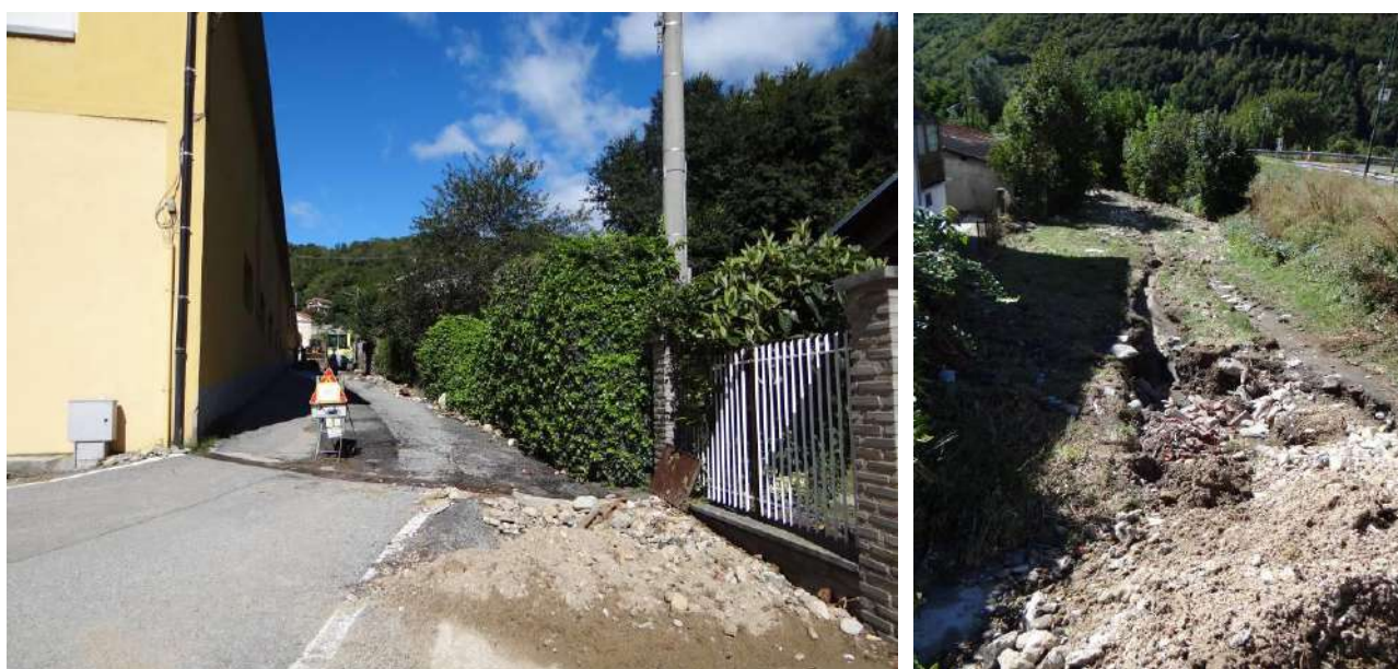
Figura 41. Via Rio Bertalotto: evidenze del passaggio dell'acqua con trasporto e deposizione di detriti, ripresa a monte (destra) e a valle (sinistra) della SR23.
