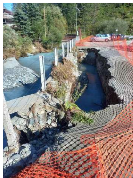
Figura 22. Comune di Balme, Pian della Mussa: sovralluvionamento in località Alpe Venoni (a sinistra) ed erosione del parcheggio (a destra).
