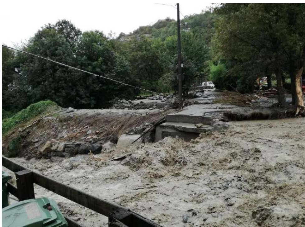
Figura 31. Ponte della frazione Combe asportato dalla piena (foto del 5 settembre, mattino, fase calante dell'evento): la piena ha asportato le spallette e la scogliera a protezione della sponda (a destra, nella foto); la strada di accesso è stata sormontata sia in destra che in sinistra del ponte, con accumulo di detrito grossolano. L'asportazione del ponte ha tranciato inoltre la condotta dell'acquedotto, di cui è visibile il tubo nero, piegato, a sinistra dell'appoggio del ponte, ed abbattuto la linea telefonica.
