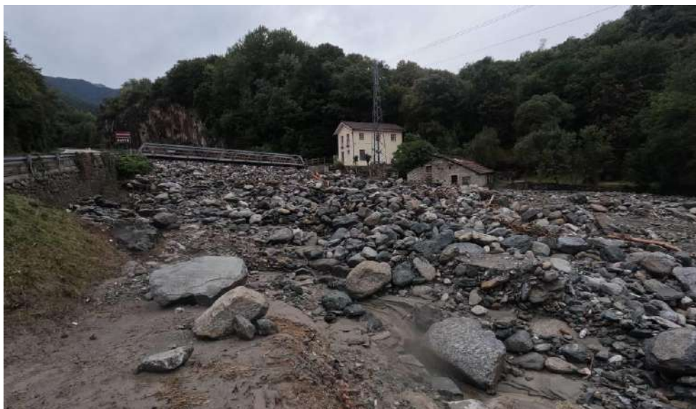
Figura 30. Alveo del rio Gerardo a monte della frazione Combe, totalmente intasato di detrito. In centro all'immagine la centrale elettrica Girardi e il relativo ponte di accesso, questi non sono stati danneggiati ma il piazzale antistante alla centrale è stato interessato da deposito di detrito grossolano; poco a destra l'antico edificio della fucina, di cui è risultato danneggiato lo spigolo del muro più prospiciente il rio.
