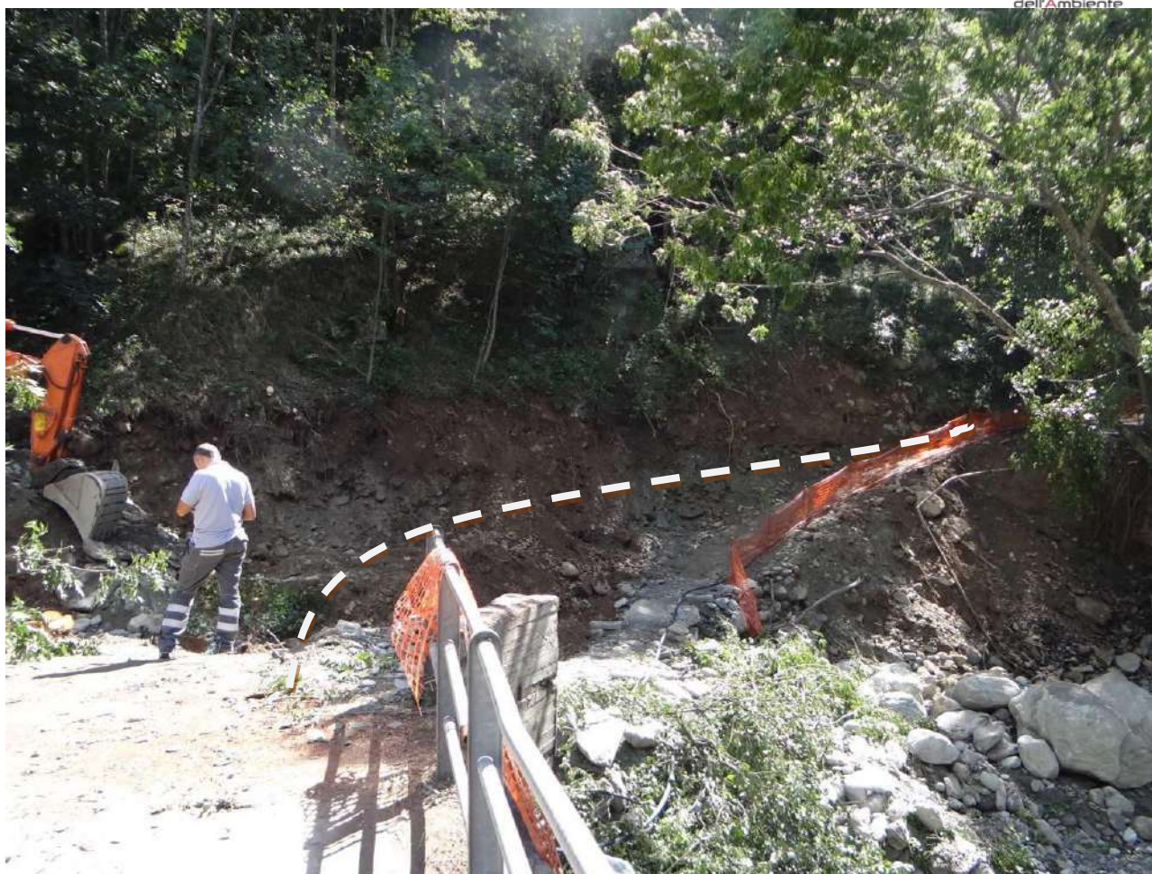
Figura 43. Passaggio della colata detritica del Rio Gleisolle con distruzione del tratto stradale della SP261 in direzione della borgata Gran Faetto (il tratteggio indica la pozione della viabilità coinvolta).
