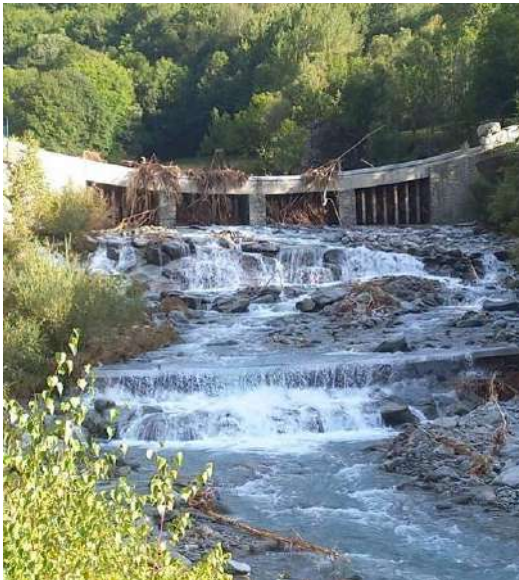
Figura 18. Comune di Groscavallo, Forno Alpi Graie: riempimento della briglia selettiva a monte dell'abitato.
