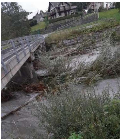
Figura 21. Accumuli di materiale vegetale e lapideo in corrispondenza del ponte in località Piazzette (comune di Usseglio, immagine fornita dall'Amministrazione comunale) e asportazione di tratto della pista fondo/mtb in località Borgo (comune di Groscavallo).
