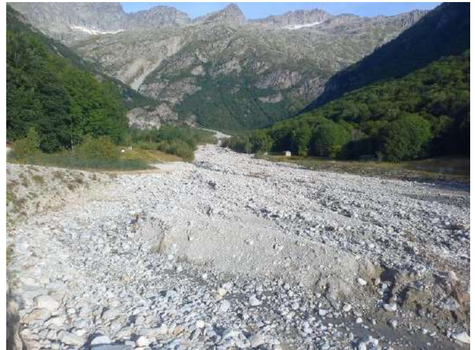
Figura 17. Comune di Groscavallo, Forno Alpi Graie: asportazione tratto di pista fondo/mtb (a sinistra), sovralluvionamento conoide Gura (a destra).
