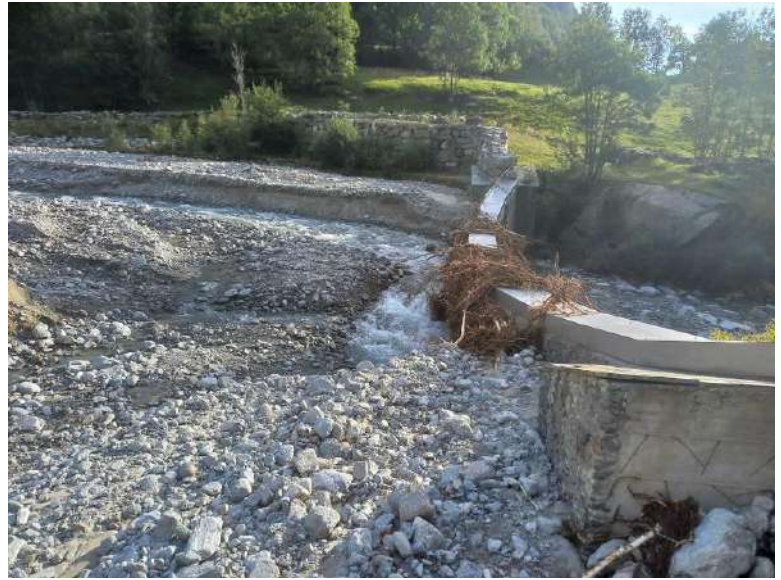
Figura 18. Comune di Groscavallo, Forno Alpi Graie: riempimento della briglia selettiva a monte dell'abitato.
