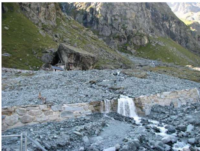
Figura 22. Comune di Balme, Pian della Mussa: sovralluvionamento in località Alpe Venoni (a sinistra) ed erosione del parcheggio (a destra).
