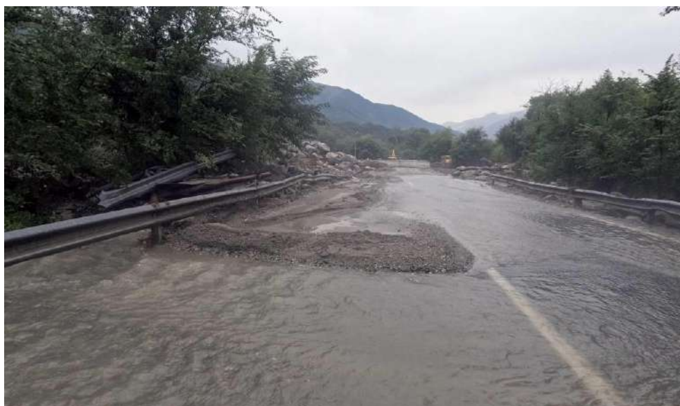
Figura 32. SP24 del Monginevro (ex SS24), poco oltre l'abitato di Bussoleno: in primo piano le acque divaganti del rio Gerardo con piccoli depositi ghiaiosi, in lontananza il ponte del rio totalmente intasato da grossi blocchi, di cui in sinistra (lato di monte del ponte) si riconosce parte dell'accumulo.
