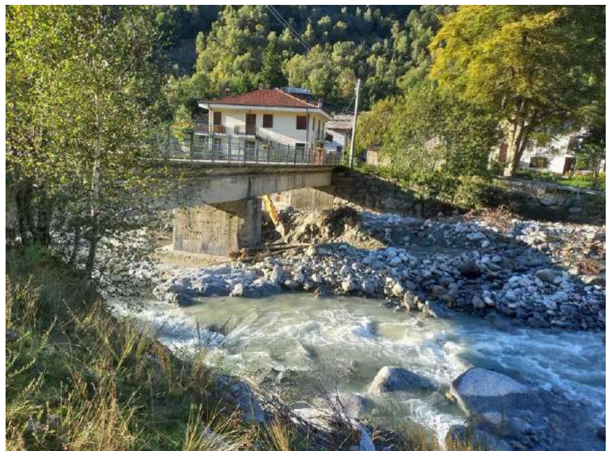
Figura 20. Comune di Groscavallo, Campo della Pietra: asportazione tratto di pista fondo/mtb (a sinistra), sovralluvionamento in corrispondenza del ponte che permette l'accesso alla borgata (a destra).
