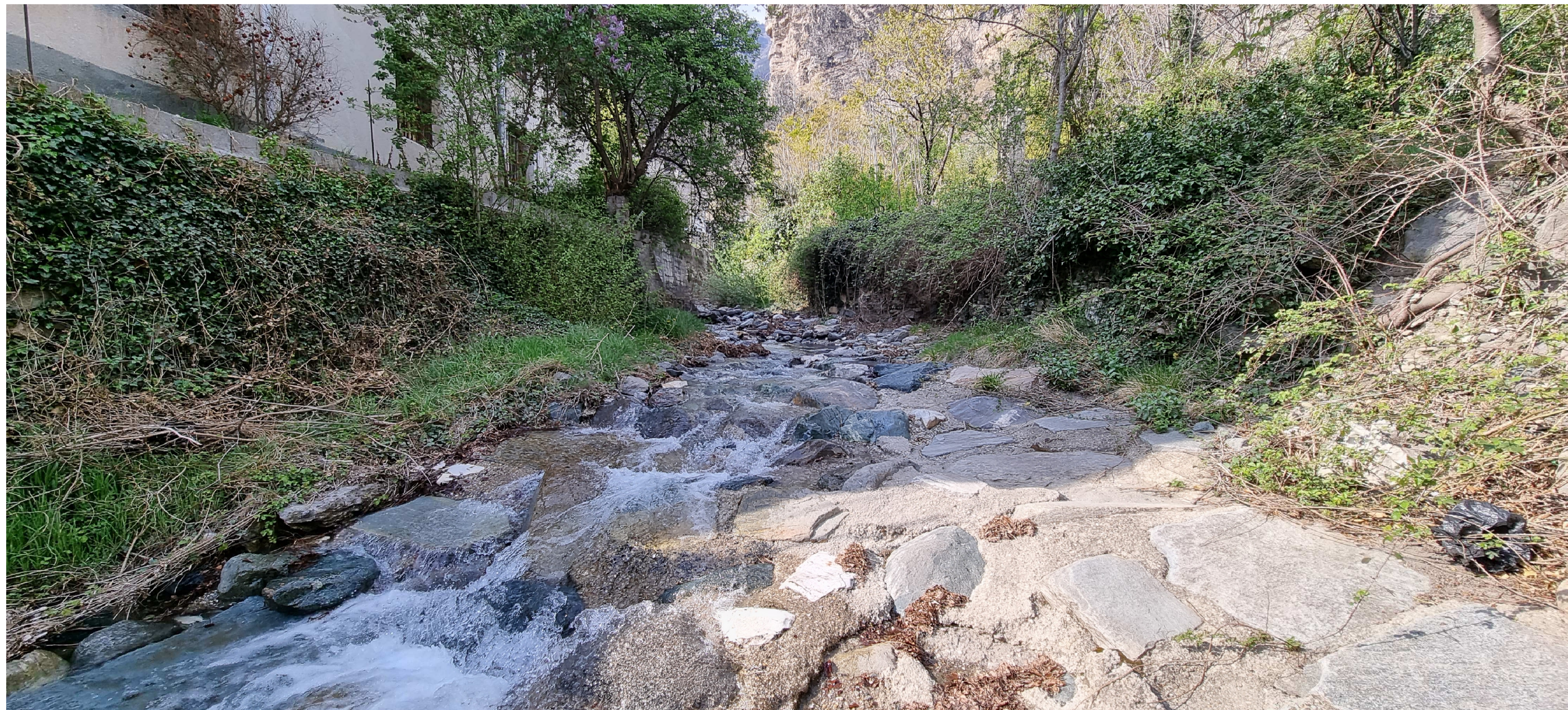
Foto 2 - Stato di fatto
