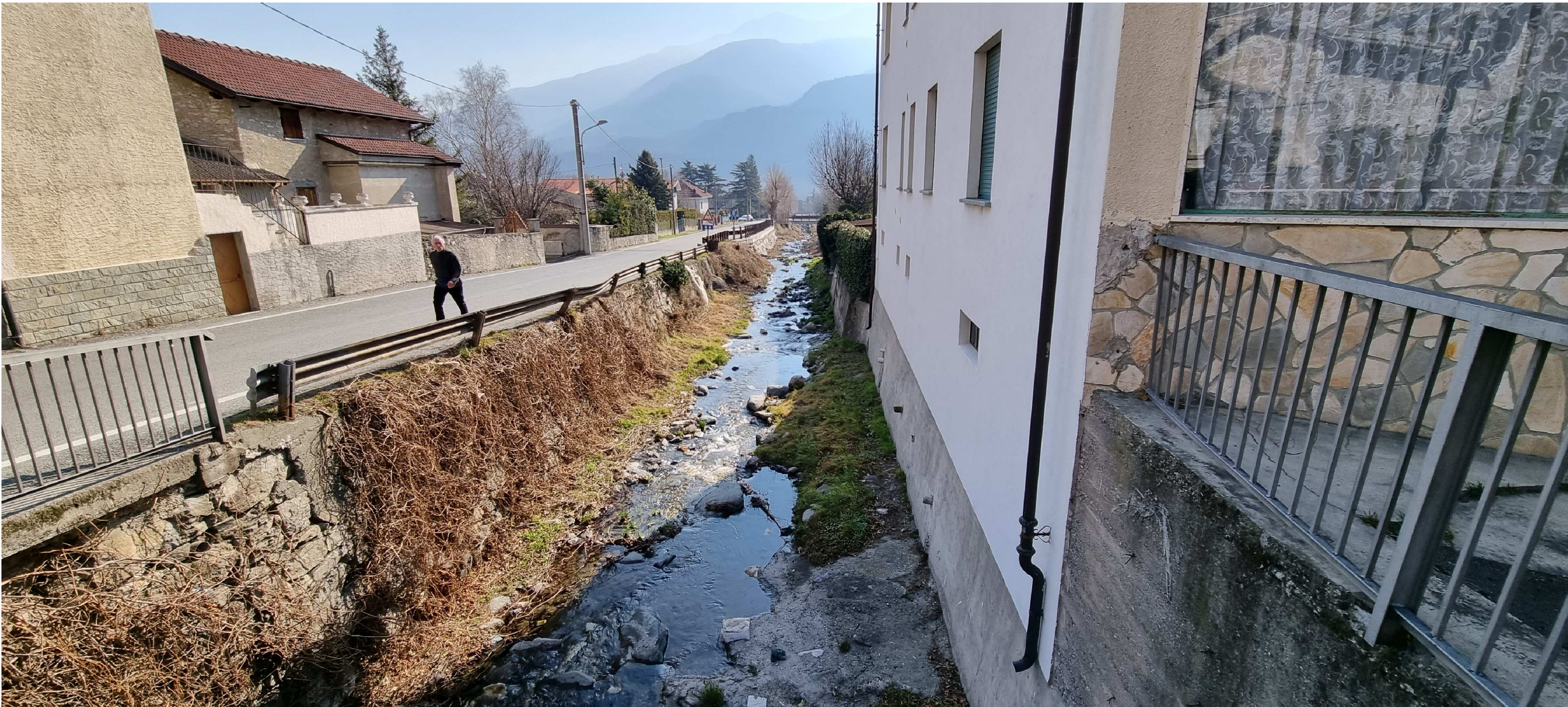
Foto 3 – Stato di fatto
